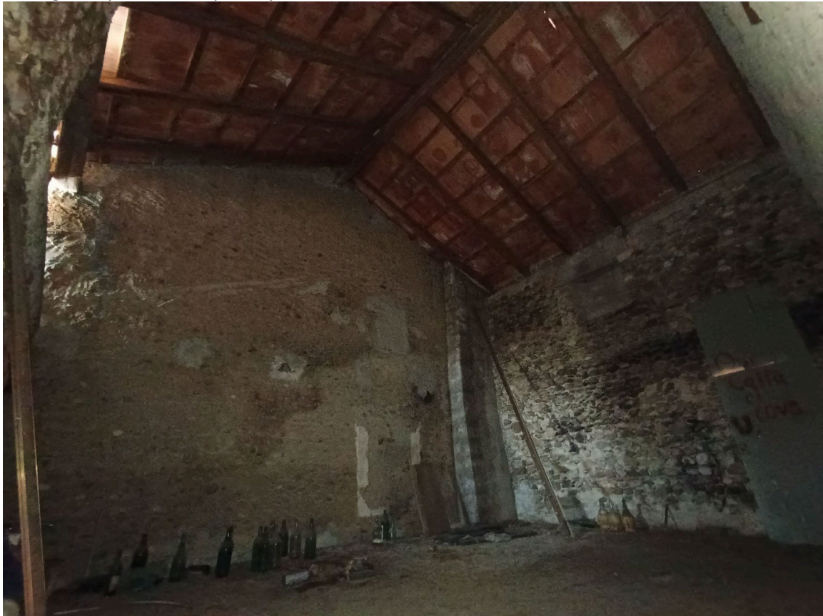
Dettaglio deposito Nord primo piano
