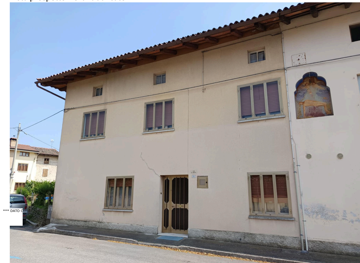
Vista prospetto Nord fabbricato
