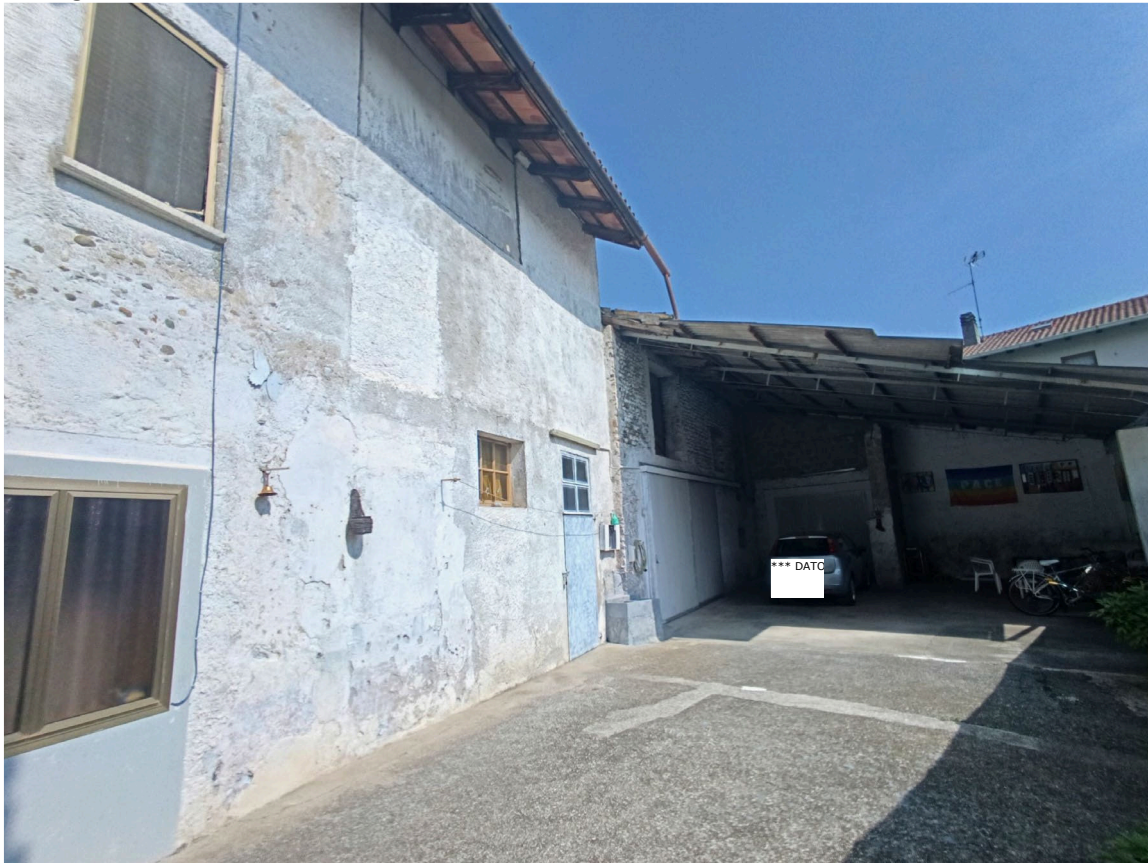
Dettaglio tettoia da demolire
