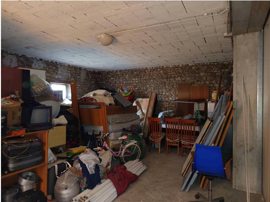
Dettaglio deposito piano terra
