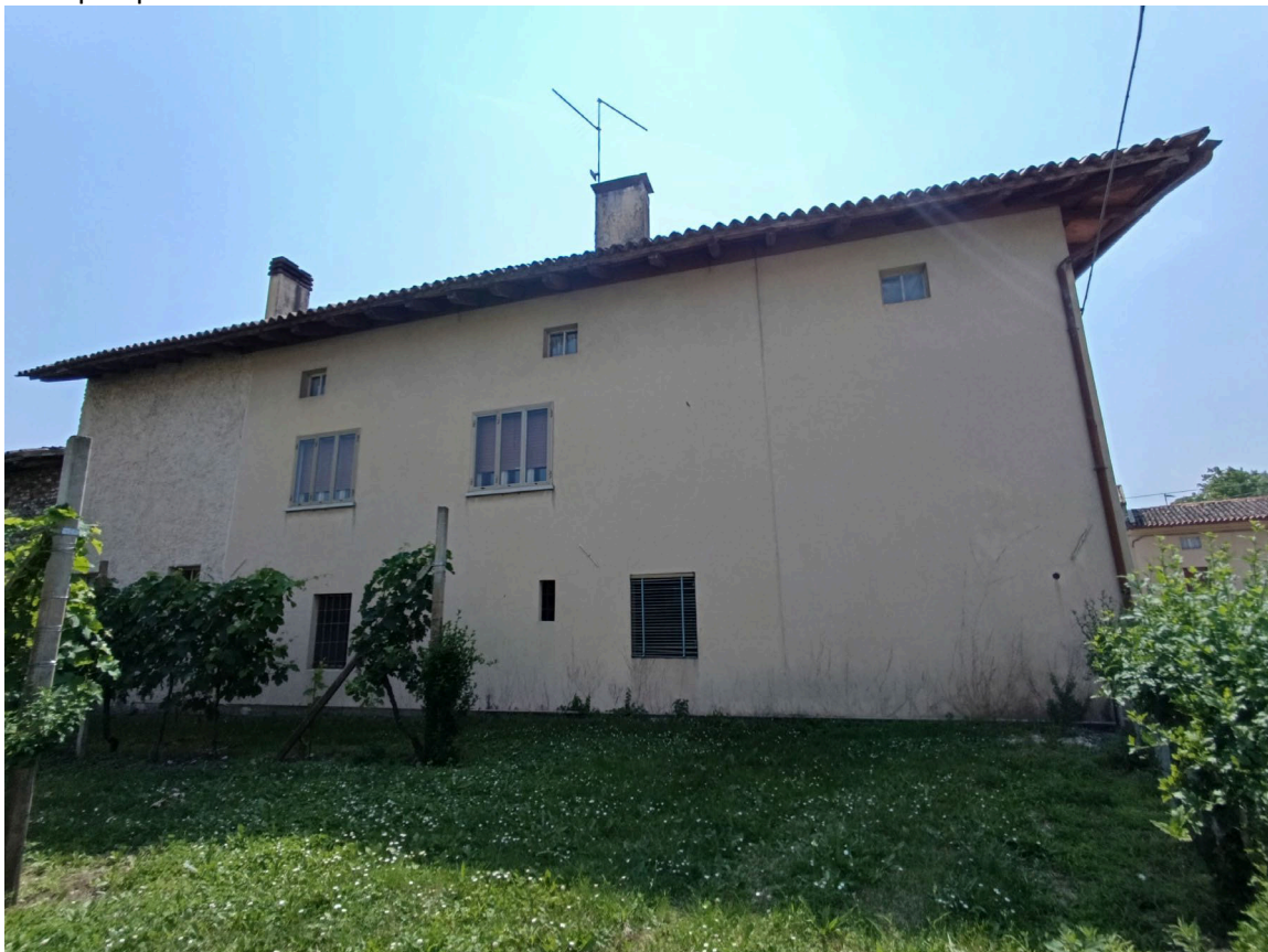
Vista prospetto Est fabbricato
