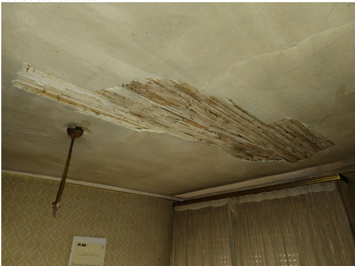
Particolare soffitto salotto
